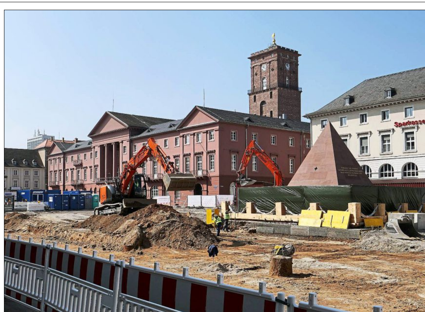
Komplett aufgebuddelt ist der Marktplatz rund um die Pyramide. Hier werden in den nächsten Wochen Leitungen verlegt. Dann erhält das Areal einen neuen Bodenbelag aus Naturstein. Gearbeitet wird abschnittsweise. Ende 2020 soll Karlsruhes gute Stube fertiggestellt sein. Foto: Sandbiller
